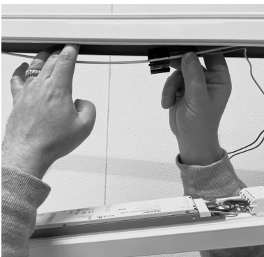
Klemmen an Drähten befestigen Fixer les bornes aux fils Fissare i morsetti ai fili
